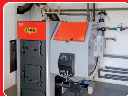
Vzorová kotelna s kotlem ROJEK TKA 25
