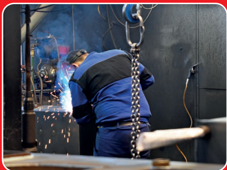
Ruční svařování kotlů
